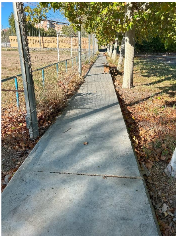
Imagen 13: Foto de la acera de hormigón existente.
