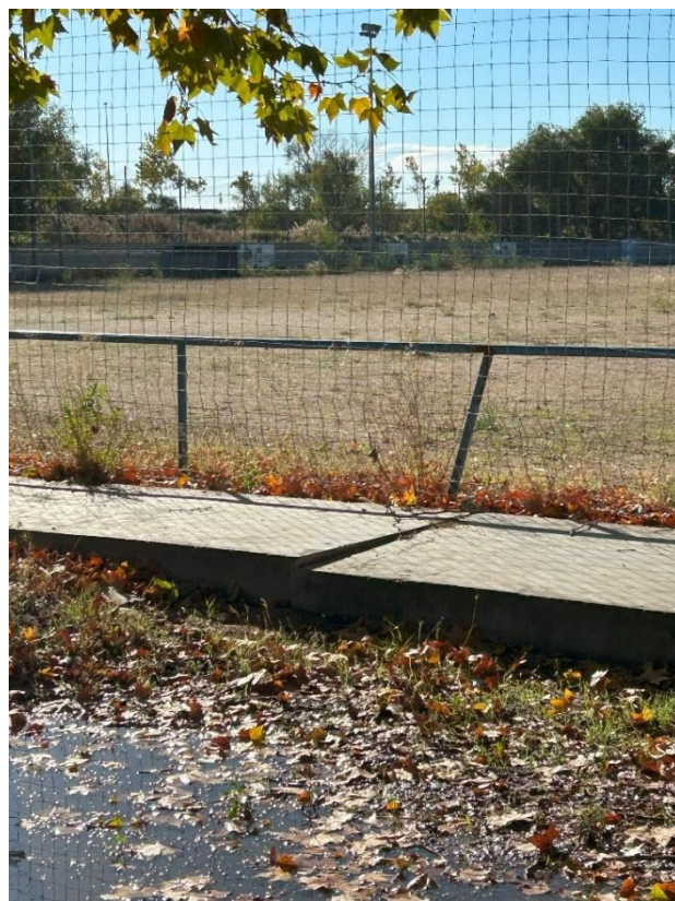
Imagen 13: Foto de la acera de hormigón existente
